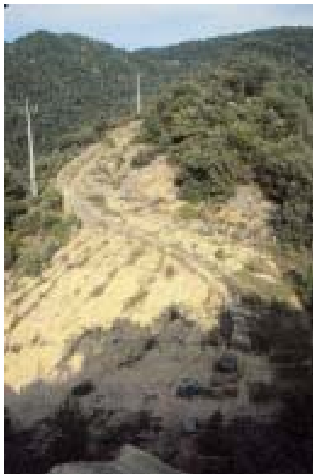
Fig. 6. Aspecte d'un tram de la via del Capsacosta.
