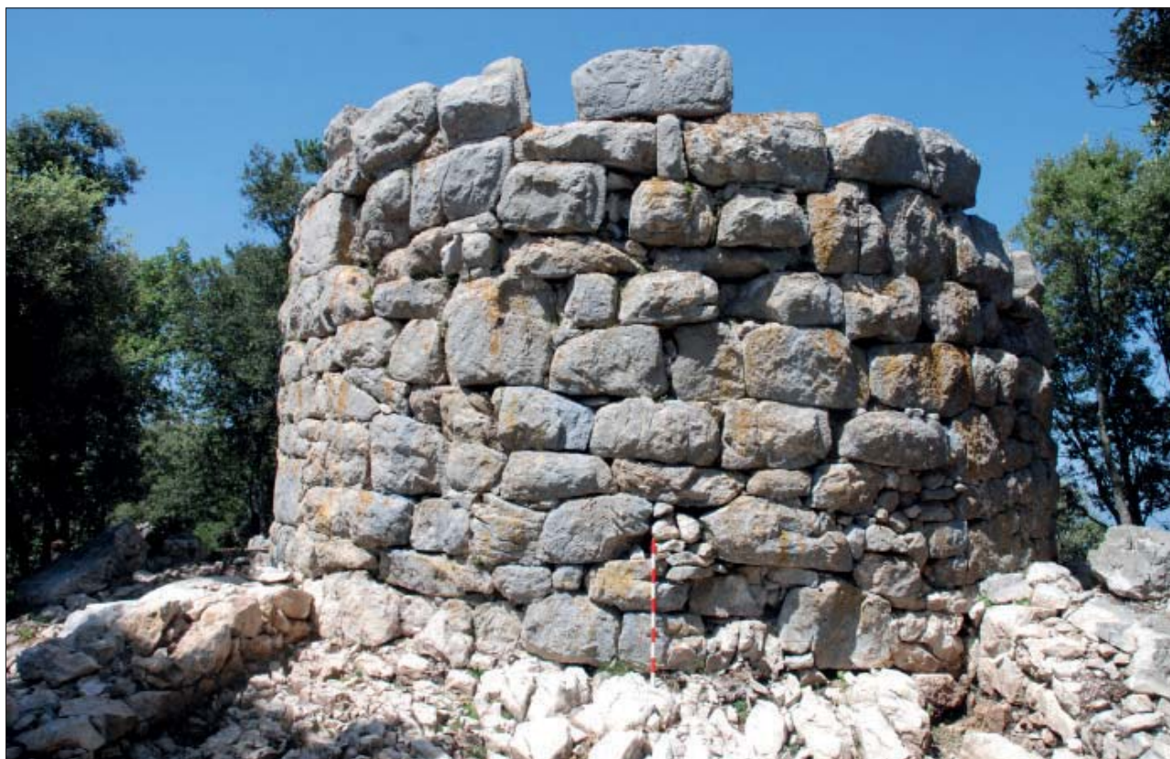
Fig. 3. Vista general de la torre des de la cara sud
